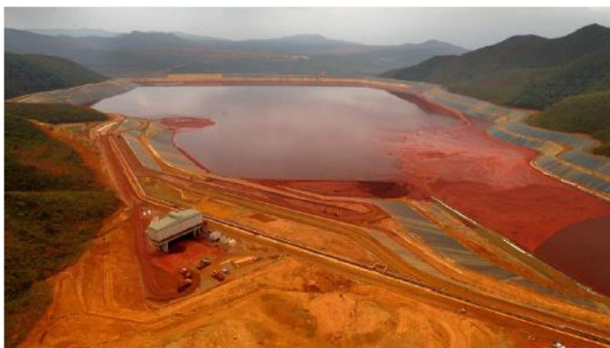
Barrage à résidus de la mine nickel-cobalt sur le plateau de Goro, en Nouvelle-Calédonie
