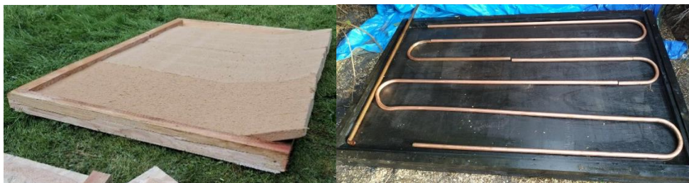
Fabrication du capteur (en cours)
