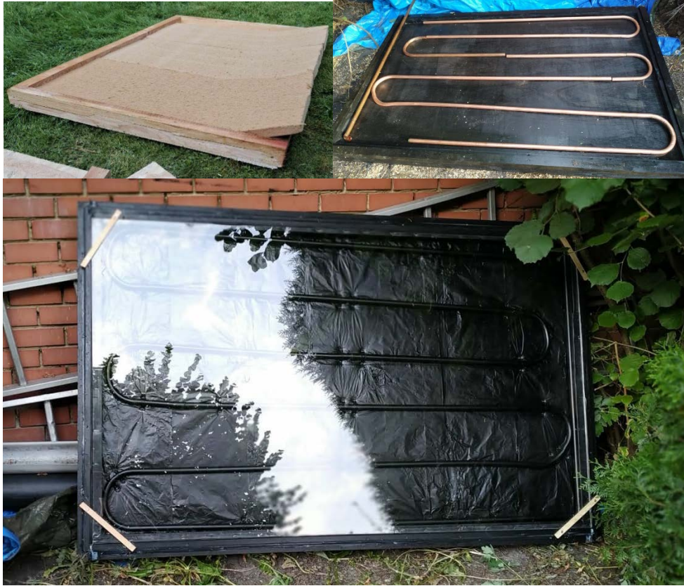
Fabrication d'un premier prototype de capteur solaire à effet thermosiphon
